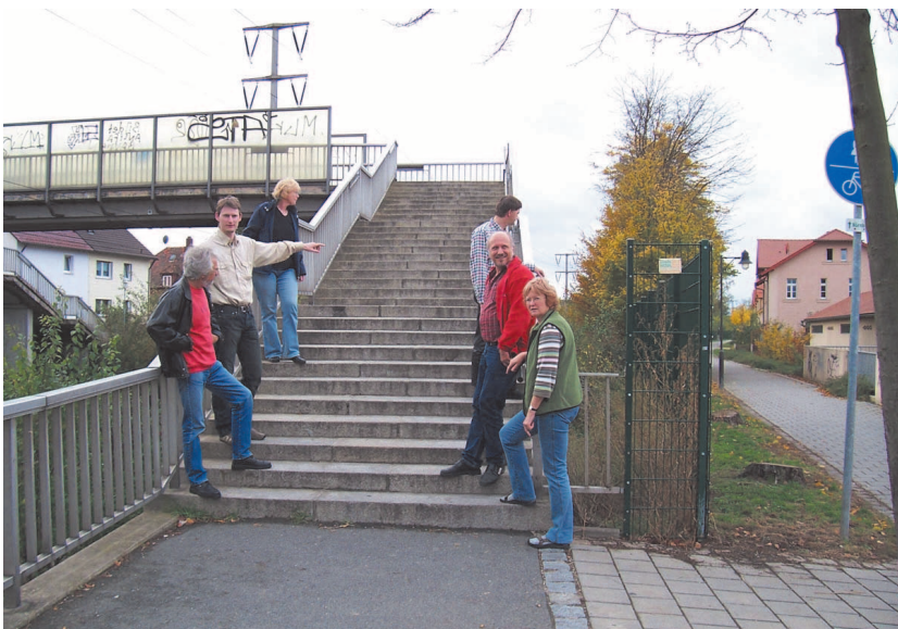
Mitglieder der Grünen bei einer Ortsbesichtigung vor dem sanierungsbedürftigen Steg
